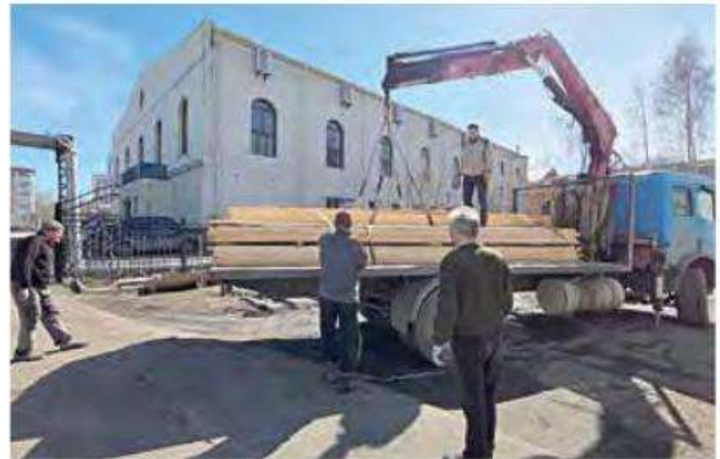
Baumaterial für das Dach wird geliefert
