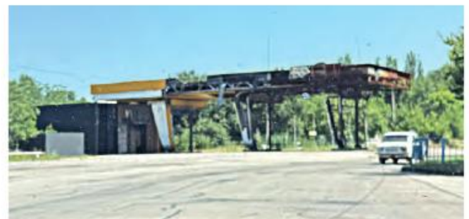
Eine zerstörte Tankstelle in Nikopol
